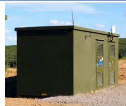
Poste de distribution public d'électricité / poste de transformation
