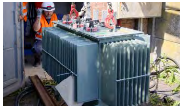
Poste de distribution public d'électricité / poste de transformation
